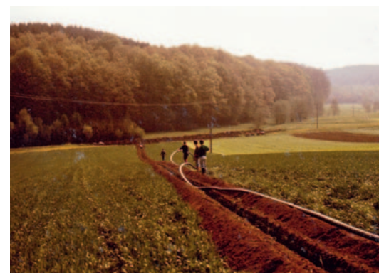
Mit dem Bau eines Wasserwerks am Huttenbach und einer 400 Meter langen Leitung wurde die Beregnung des neuen Hauptspielfeldes möglich.
