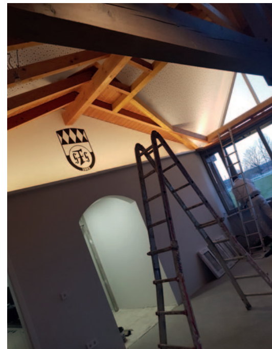
Es sieht schon ganz gut aus im Innenbereich.
