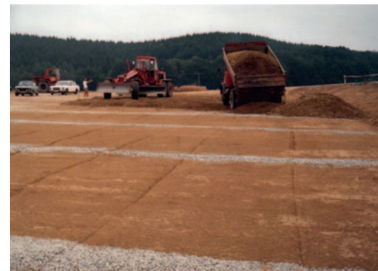
Der Untergrund ist fertig, jetzt geht's langsam an die oberste Schicht.
