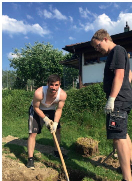
Matthias Neuer und Lukas Rohmer ebenfalls am Aushub einer Station.
