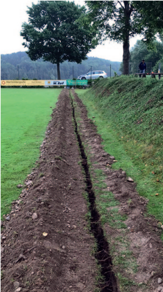
Viermal die gesamte Länge, dann noch zweimal quer musste gefräst werden.
