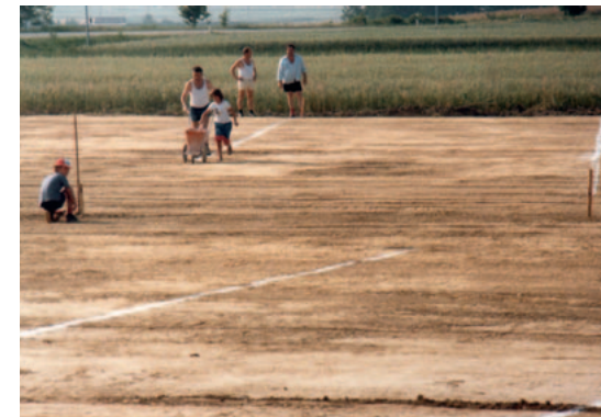
Markus Lauber, Walter Lauber, Elke Seeberger (ehemals Lauber), Egbert Heinz und Manfred Brendel beim Markieren wo die Sickerleitungen verlegt werden.
