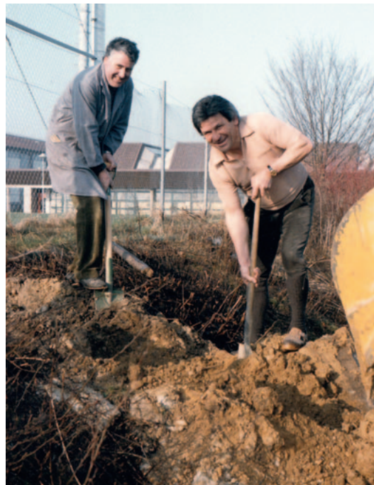
Der Spatenstich wurde von Walter Lauber und Alois Schill am 18.04.1987 zelebriert.
