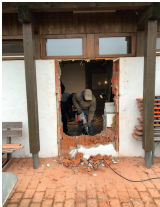
Florian Jöchle bei Abrissarbeiten, um den neuen Haupteingang zu bauen.
